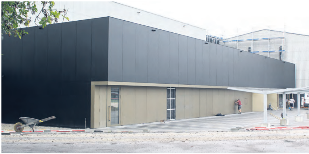
In der neuen Halle trainiert vorübergehend auch die Männerriege.
