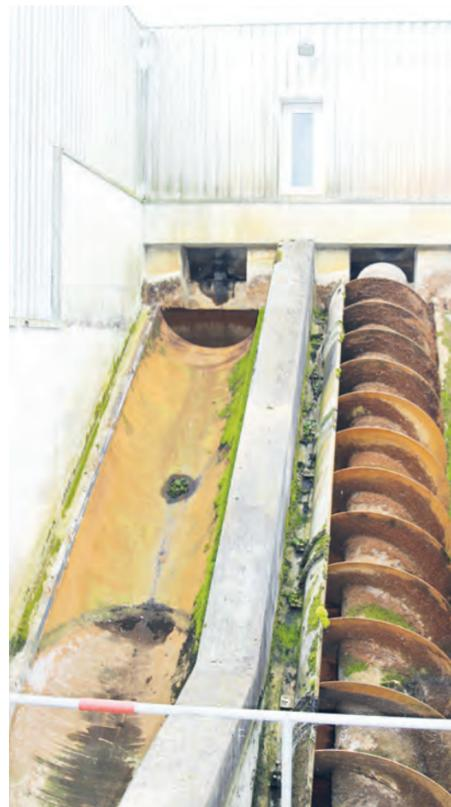
Die Schneckenpumpen (r.) aus dem Jahr 1996 wurden durch vier neue Kanalradpumpen (l.) ersetzt.
