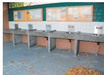
Der Abwaschplatz wird überdacht und die Zahl der Waschplätze wird verdoppelt.
